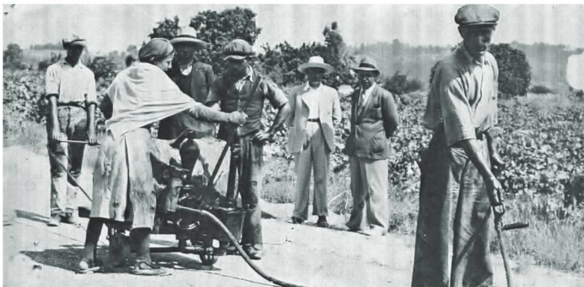
Εργα οδοποιίας στο επαρχιακό οδικό δίκτυο Πατρών - Πύργου αρχές δεκαετίας '50. Ο Ξενοφών Παπαευθυμίου διακρίνεται στο βάθος πίσω από το συνεργείο του (αρχείο Ξενοφώντα Παπαευθυμίου)
