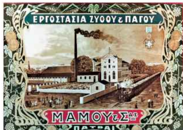
☉ Καλλιτεχνική σύνθεση της εποχής. Προπολεμική καρτ-ποστάλ με τις εγκαταστάσεις του Μάμου. Διακρίνεται και το τρένο της γραμμής.
